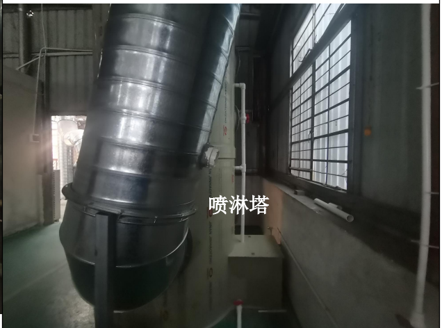
图 4 喷淋塔（喷淋塔已设置汽水分离器，用以除去气体中夹带的水份）
